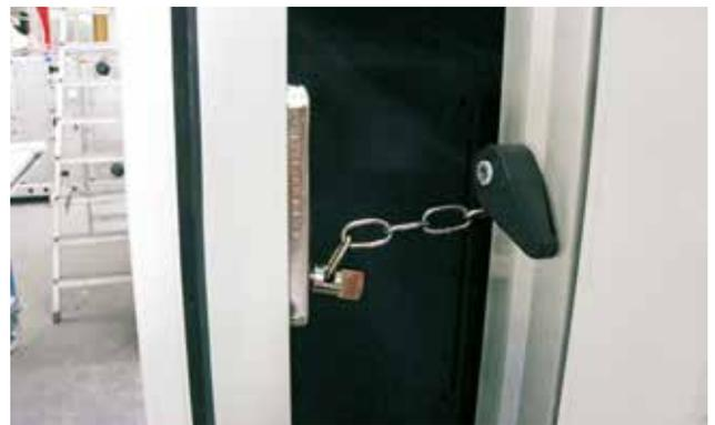
*Bild 23:* Alle Überdrucktüren sind zusätzlich mit einer Verriegelungskette gesichert.
