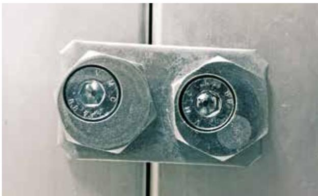
*Bild 21:* Verbinden Sie die inneren Klemmen und spannen sie die Excenter durch drehen mit einem Maulschlüssel. Sichern Sie die Excenter mit M8x25-Schrauben. Schrauben sind in der Lieferung enthalten.
