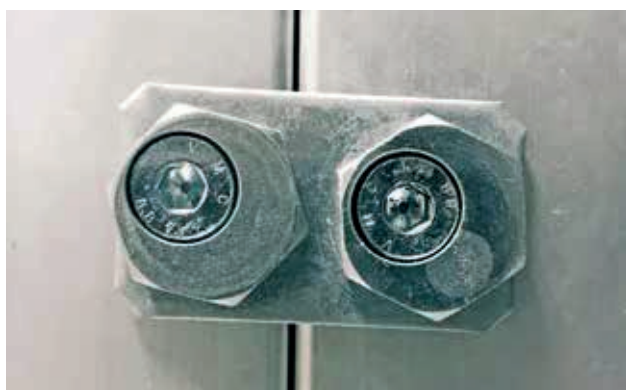
Рис. 21. Соедините внутренние скобы специальными эксцентриковыми винтами М8х25. Винты включены в отдельный комплект поставки.
