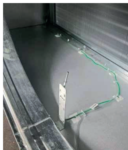
Slika 53: Tipalo temperature dovodnega zraka. Priključi se v priključni dozi, ki se nahaja za dovodnim ventilatorjem (zeleni konektor, gl. Slika 54).
