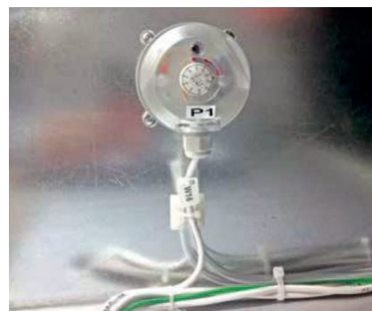
Slika 50: Stikalo diferenčnega tlaka za filtre za sveži ali odvodni zrak.
