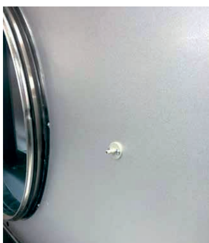
Slika 52: Prikluček za cevko za merjenje tlaka v kanalu. Uporabnik mora priloženo cevko namestiti na prikluček. Drugi konec cevke se priključi na odvodni kanal. Isti postopek se ponovi na dovodu. Znotraj naprave mora biti cevka nameščena na notranje priključke.
