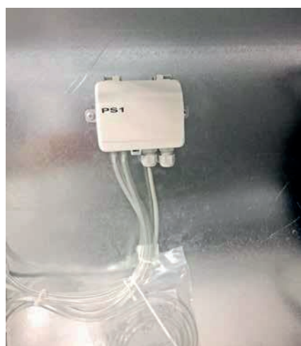
Slika 51: Tlačni senzor z dvema diferenčnima senzorjema tlaka. Uporablja se za merjenje tlaka v kanalu in zračnega pretoka dovodnih in odvodnih ventilatorjev.
