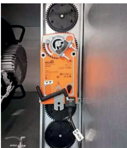
Slika 55: Pogon loput za sveži in odvodni zrak.
