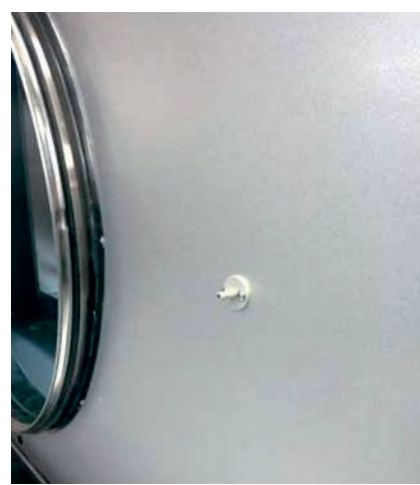
Slika 51: Priključek za cevko za merjenje tlaka v kanalu. Uporabnik mora priloženo cevko namestiti na priključek. Drugi konec cevke se priključi na odvodni kanal. Isti postopek se ponovi na dovodu. Znotraj naprave mora biti cevka nameščena na notranje priključke.
